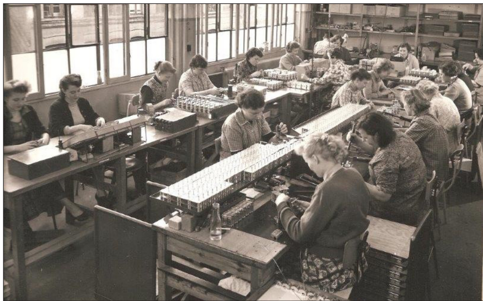
Montagedamer ved arbejdet på MEC. (Foto fra 1954).
