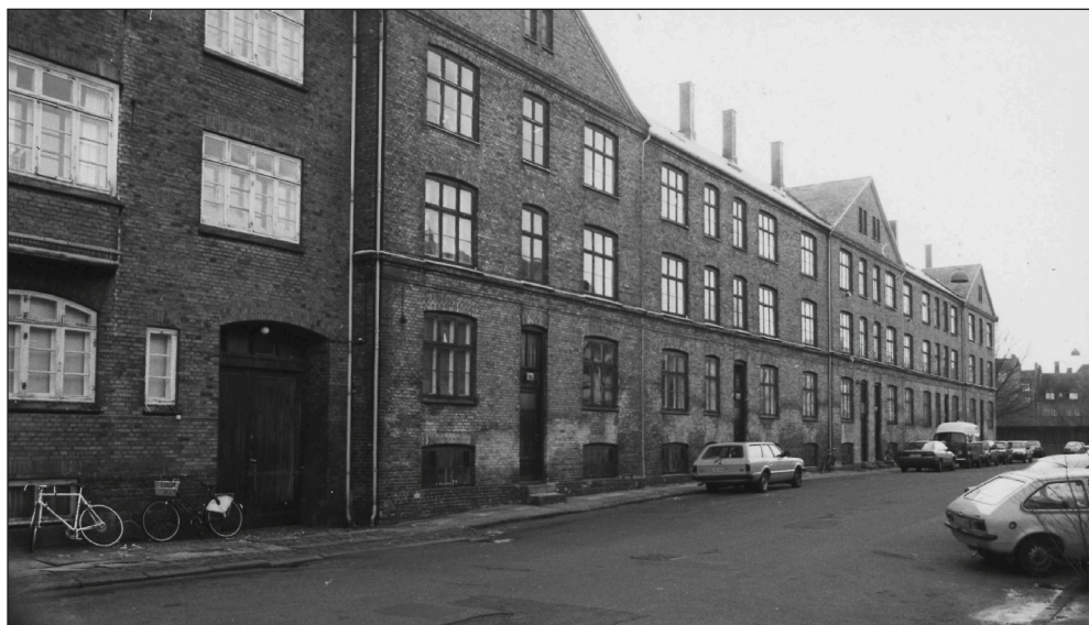
Arbejderboligerne på Holger Petersens Tekstilfabrik blev opført i 1885 og var et forsøg på at skabe en fælles husholdning (familistère) mellem fabriksejer og arbejdere. (Foto: KSJ 1991).
