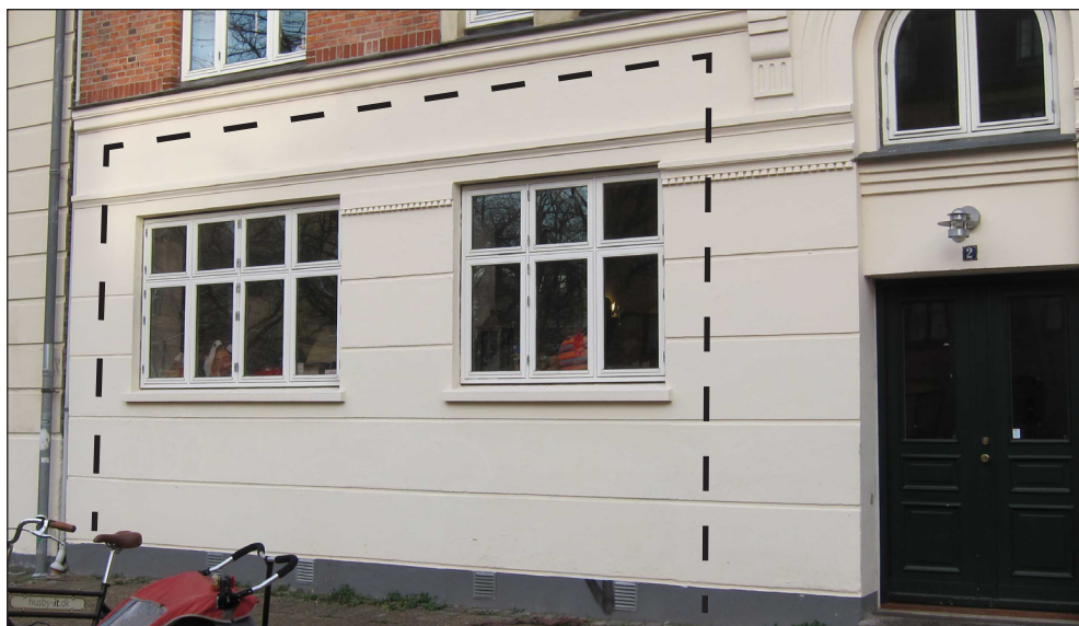
Bagerforretningen er i dag omdannet til almindelig lejlighed. (Foto: KSJ 2013).
