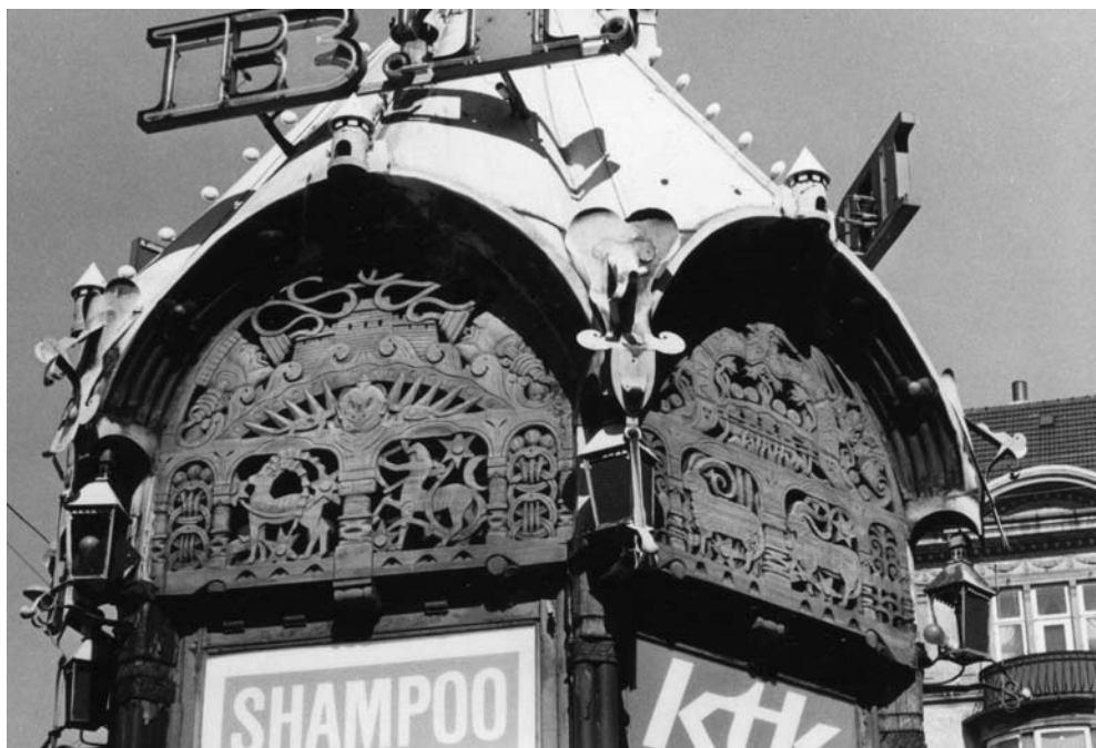
Nærbillede af billedskærerarbejderne under taget. Billedet er af kiosken ved krydset Østebrogade-Jagtvej.
